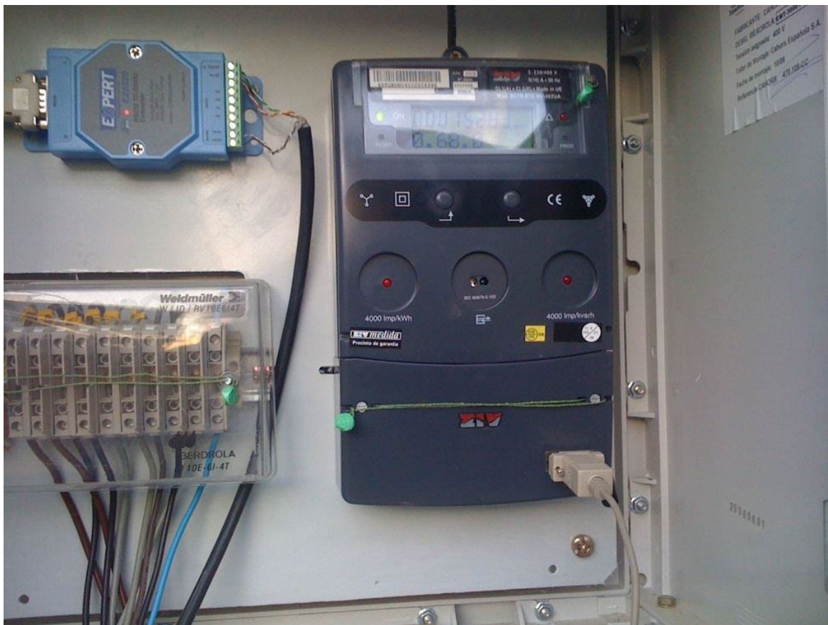
Figura 2. Contador de energía con convertidor RS232.
